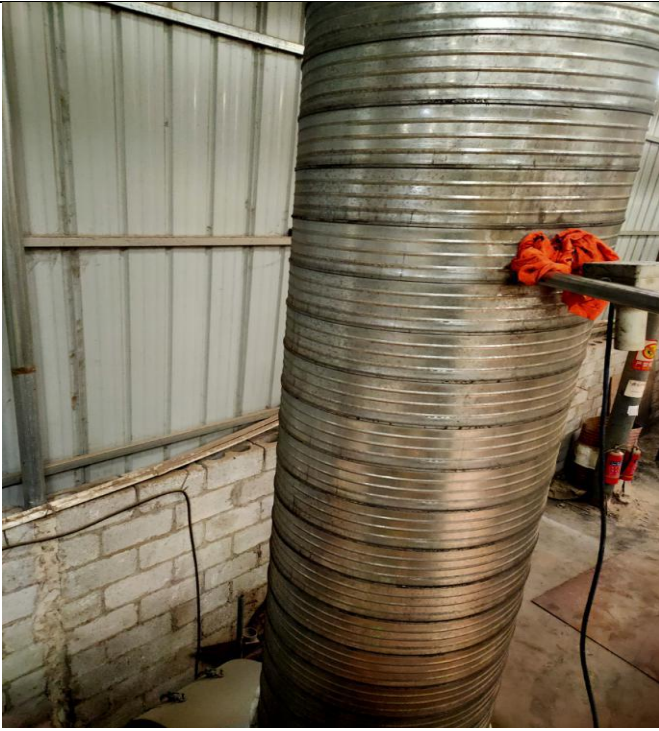
热压工序废气排放口
