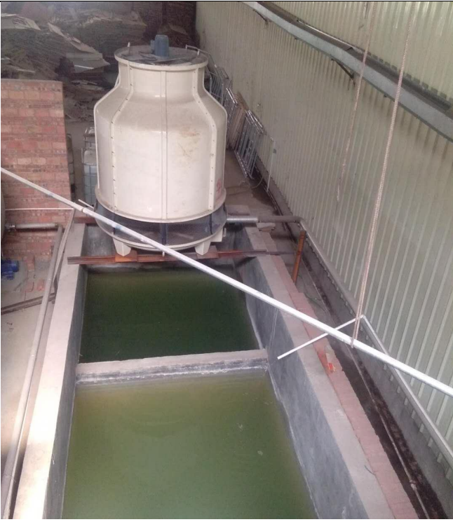
冷却塔、制胶用水收集池
