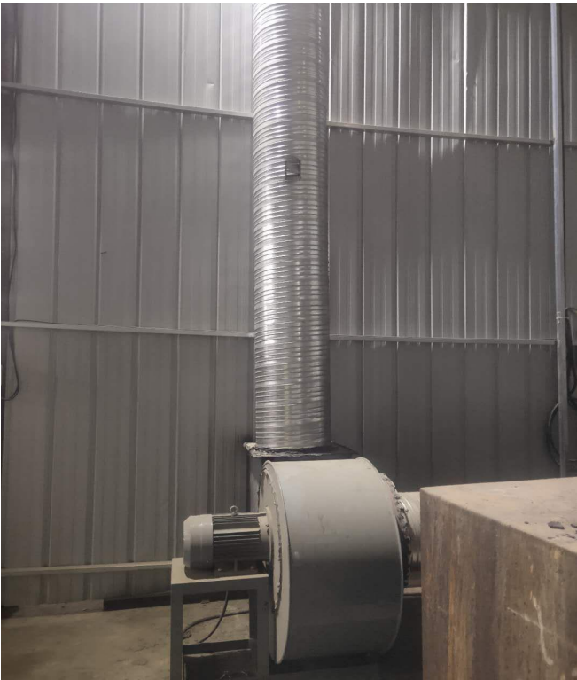
制胶车间废气采样口
