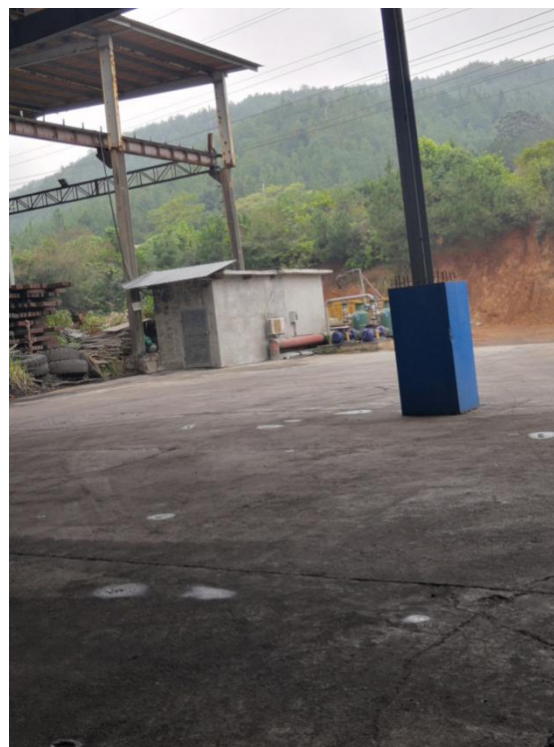
加热炉烟气在线监控室
