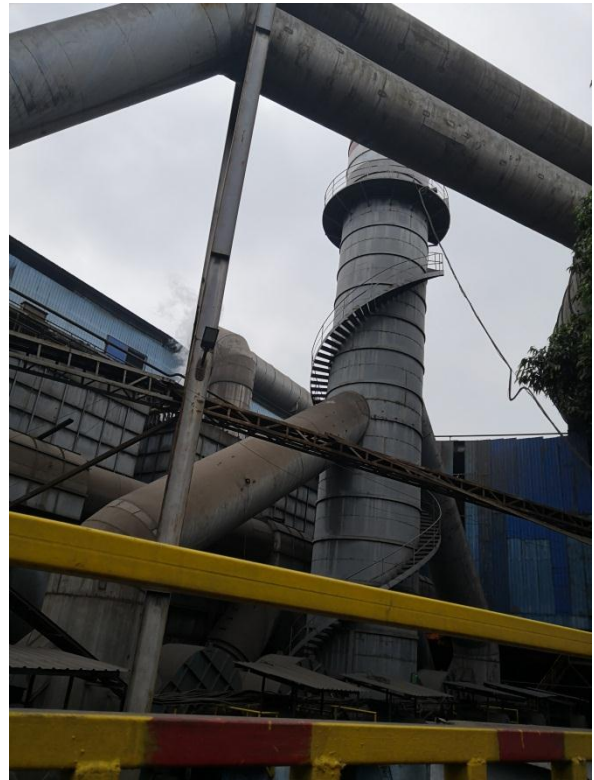
2#电炉狗屋屋顶烟气
