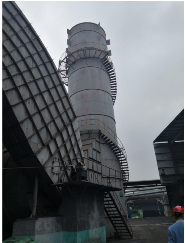
1#电炉狗屋+屋顶烟气
