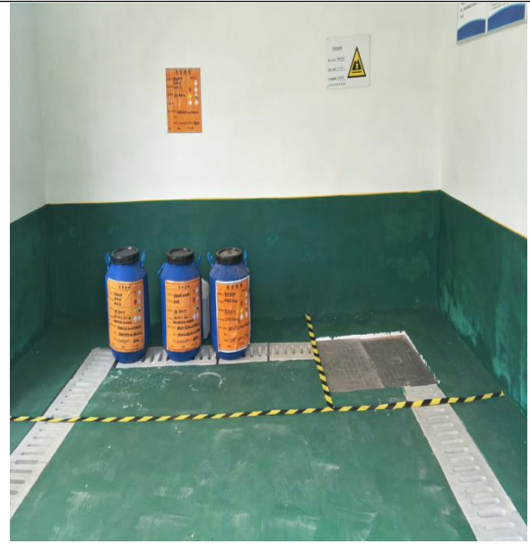
危废标识牌、区域划分线、防渗地面
