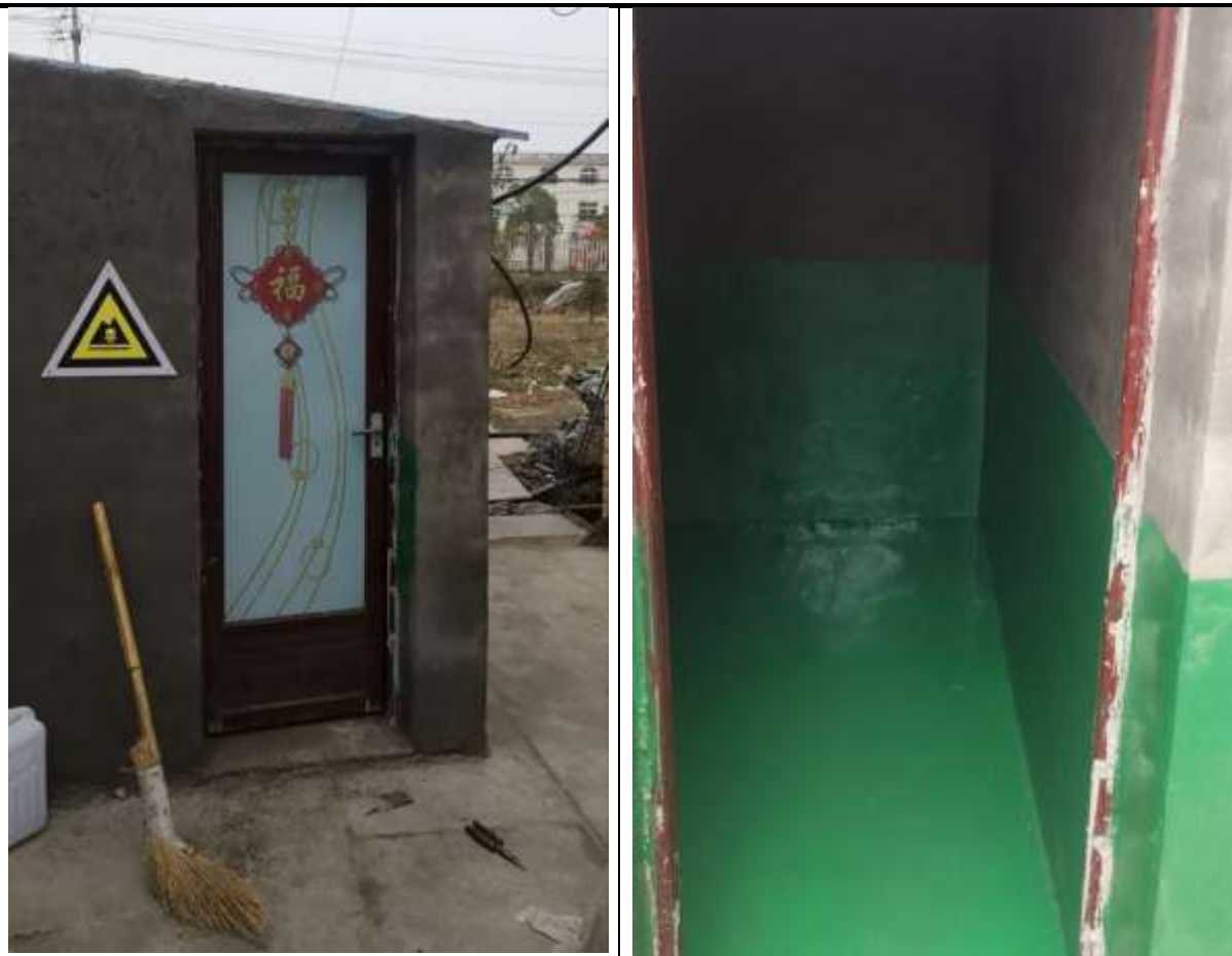
图 3-2 危废暂存间现场情况
