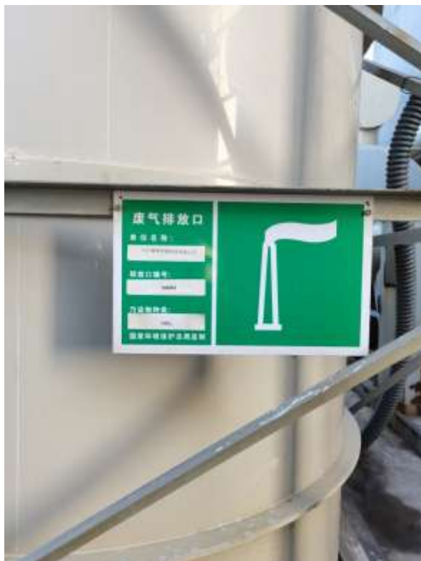
料坑、预处理车间、炉渣烘干及暂存车间废气排气筒标识牌
