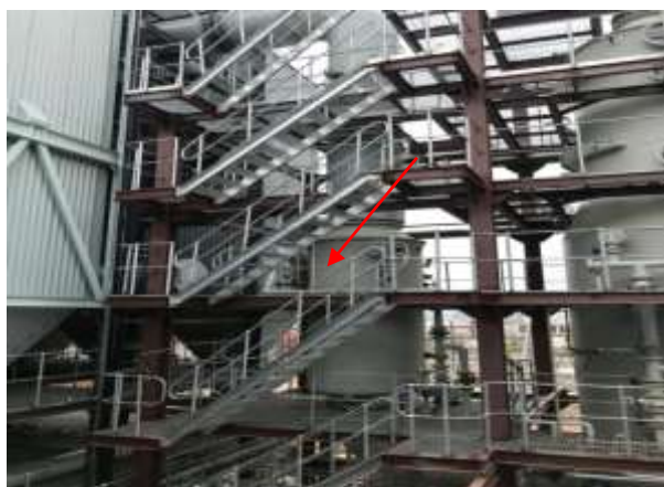
两级湿法洗涤塔（酸洗涤塔、碱液喷淋塔）
