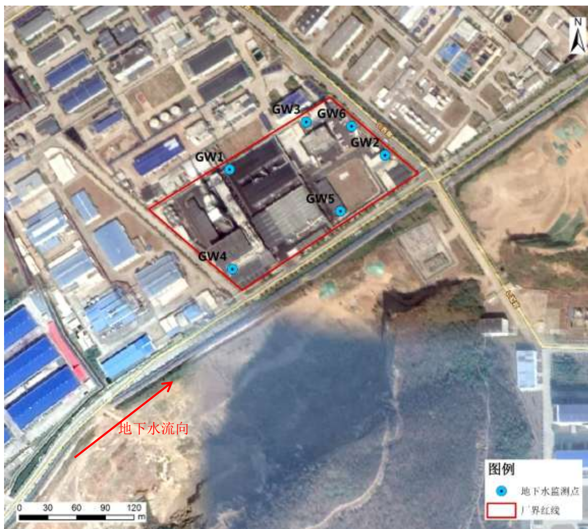
图 4-12 地下水跟踪监测井（孔）情况图
