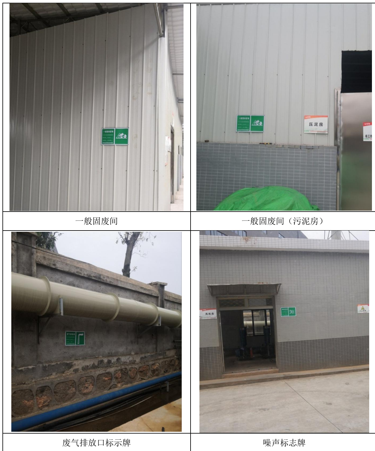
图 8-2 排放口规范化现场情况
