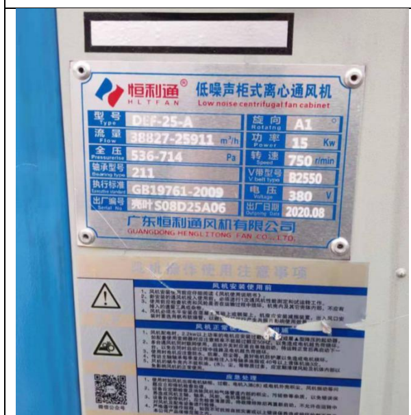
油烟风机铭牌
