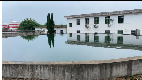
500 立方消防水池
