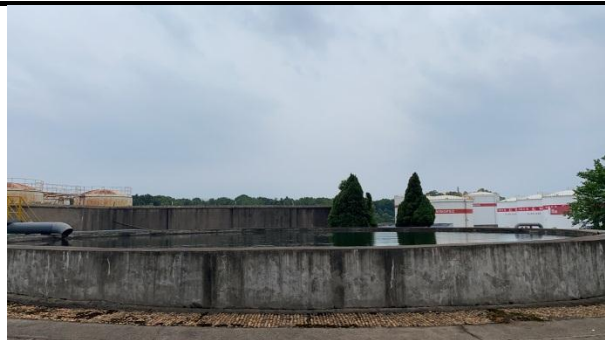
500 立方消防水池
