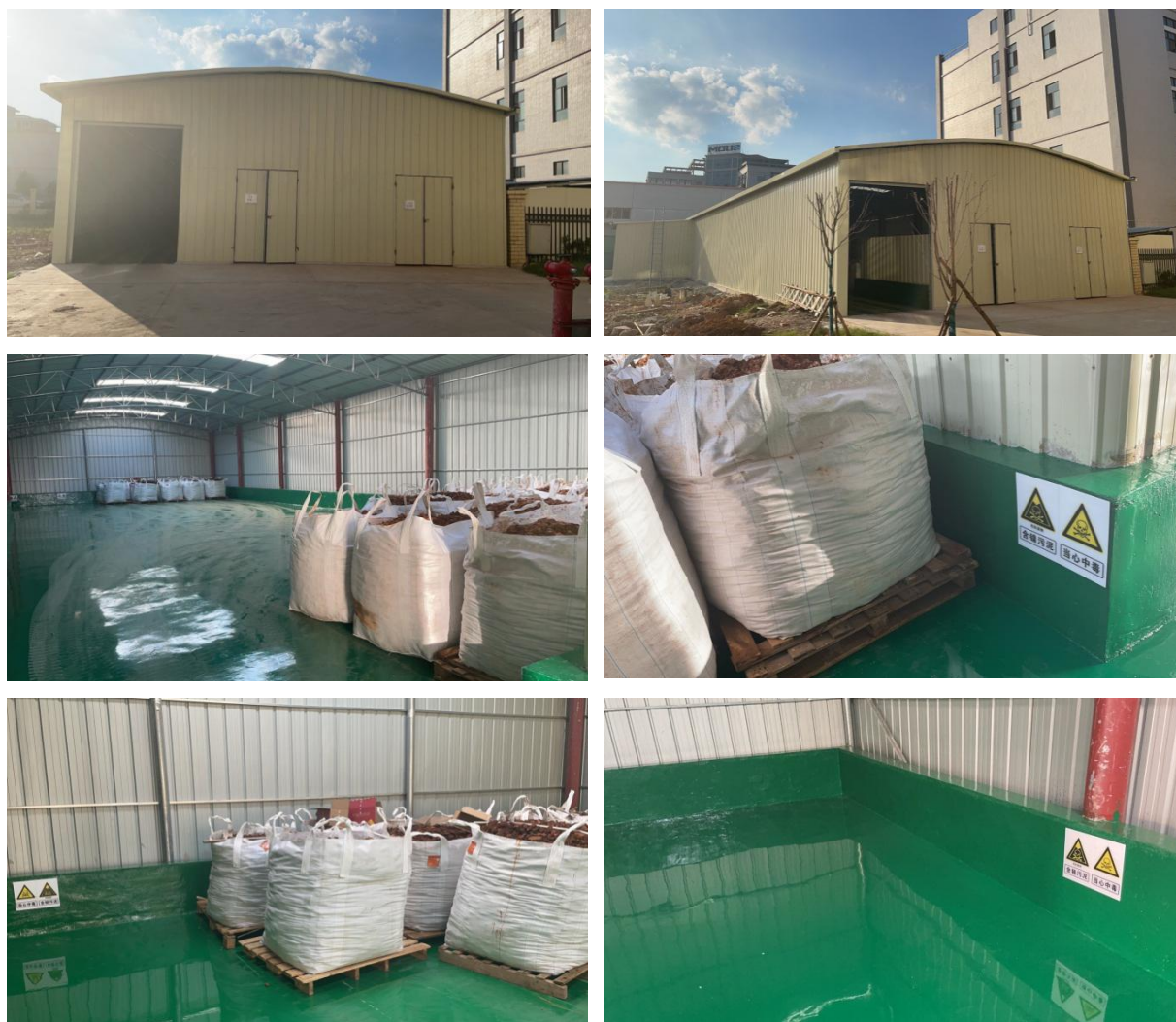
图 4-4 危废间现场情况
