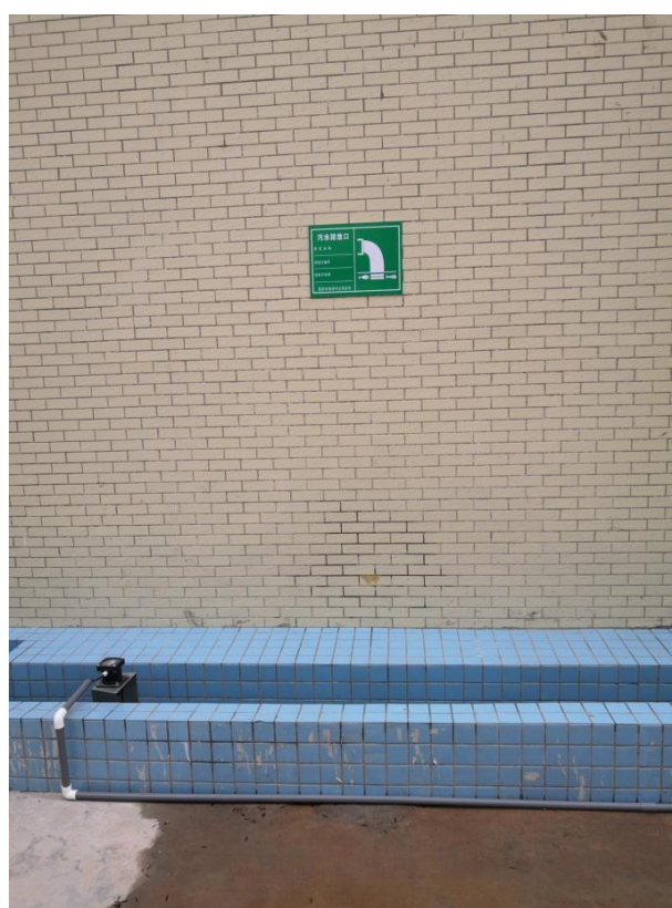
废水总排口标识牌
