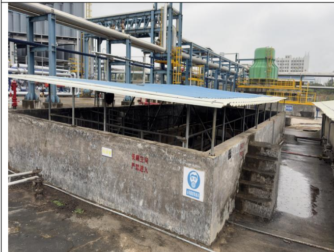
集液罐围堰及防雨措施
