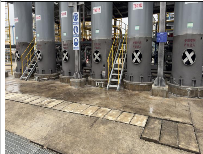
6#PSA 单元装置地面硬化情况
